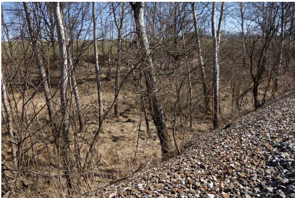
Obr. 13 (22.3.2022, km 113,800) – Pohled na zamokřené území vpravo od trati ve směru staničení (na snímku vlevo). Zamokřené území neovlivňuje stabilitu násypového tělesa, nejsou zde pozorovány žádné výrazné poruchy ani propady nivelety. Odvodnění bude částečně řešeno otevřenými příkopy, částečně odřezem na terén.
