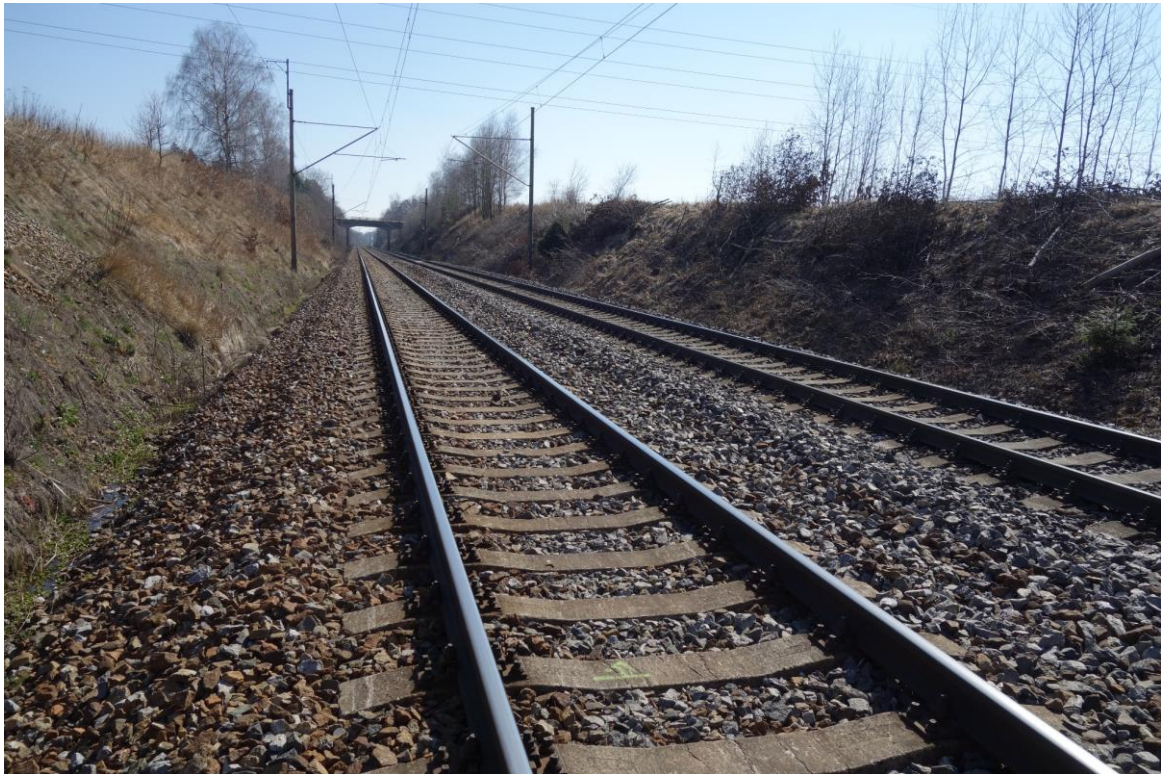
Obr. 15 (22.3.2022, km 113,500) – Zářezy mezi km 113,050 až km 113,650. Trať zde klesá ve sklonu 3,6 ‰. Odvodnění je navrženo z příkopových žlabovek UCH, za zadní zídku příkopové žlabovky lze vložit kabelové trasy. Skalní svahy budou očištěny od vegetace a zpevněny drátěnou sítí připevněnou skalními kotvami.
