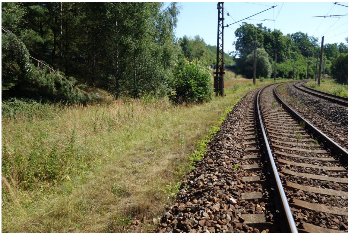
Obr. 11 (5.8.2022, km 114,200) – Pohled na zarostlé území mezi silnicí I/19 a železniční tratí. Odvodnění zde bude zajištěno pomocí příkopu zpevněného tvárnicemi TZZ3.
