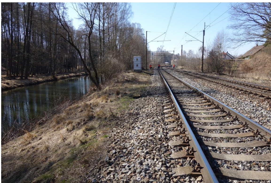
Obr. 12 (22.3.2022, km 114,600) – Pohled ve směru od Brna k zastávce Pohledští Dvořáci. Odvodnění koleje č. 1 bude zajištěno odřezem na terén. Svah bude zpevněn pohozem z lomového kamene do úrovně 0,5m nad úroveň Q100.
