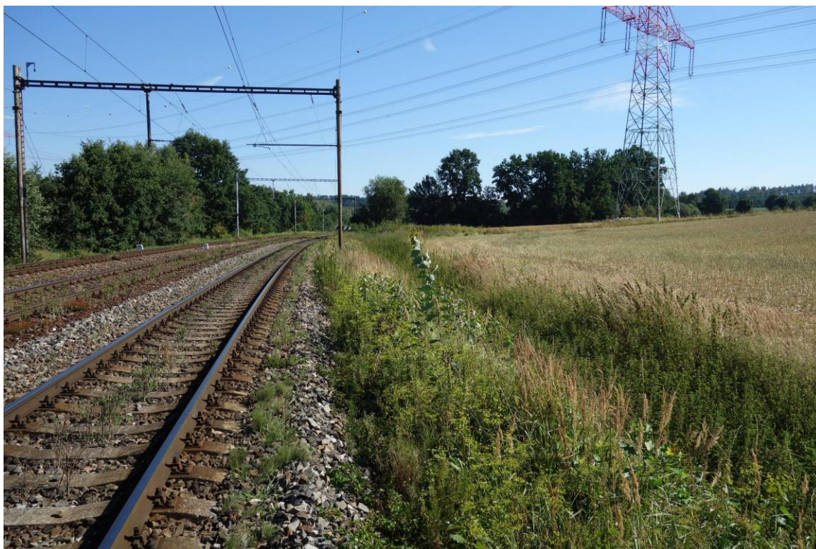
Obr. 4 (5.8.2022, km 115,700) – Pohled na drážní příkop po levé straně. Bude navrženo odvodnění z tvárníc TZZ3, na vnější straně příkopu bude zřízen zemní val sloužící jako ochrana proti vyplavování zeminy z pole do drážního odvodnění.
