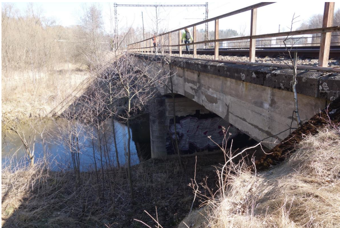
Obr. 7 (22.3.2022, km 115,249) – Pohled na most ev. km 115,249. Nosná konstrukce mostu bude zachována, bude zřízena nová izolace a římsy. Most bude sanován.
