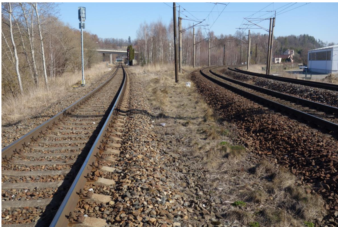
Obr. 8 (22.3.2022, km 115,150) – Pohled na místo, kde se odděluje kolej č. 90N (ve směru na Hlinsko) od kolejí č. 1 a 2 (směr na Brno). Kolej 90N bude odvodněna odřezem na terén (na obrázku vlevo), podél koleje č. 2 bude zřízen příkop vyústěný do vodního toku pod mostem v ev. km 114,970. Kolej č. 1 bude odvodněna odřezem na terén.
