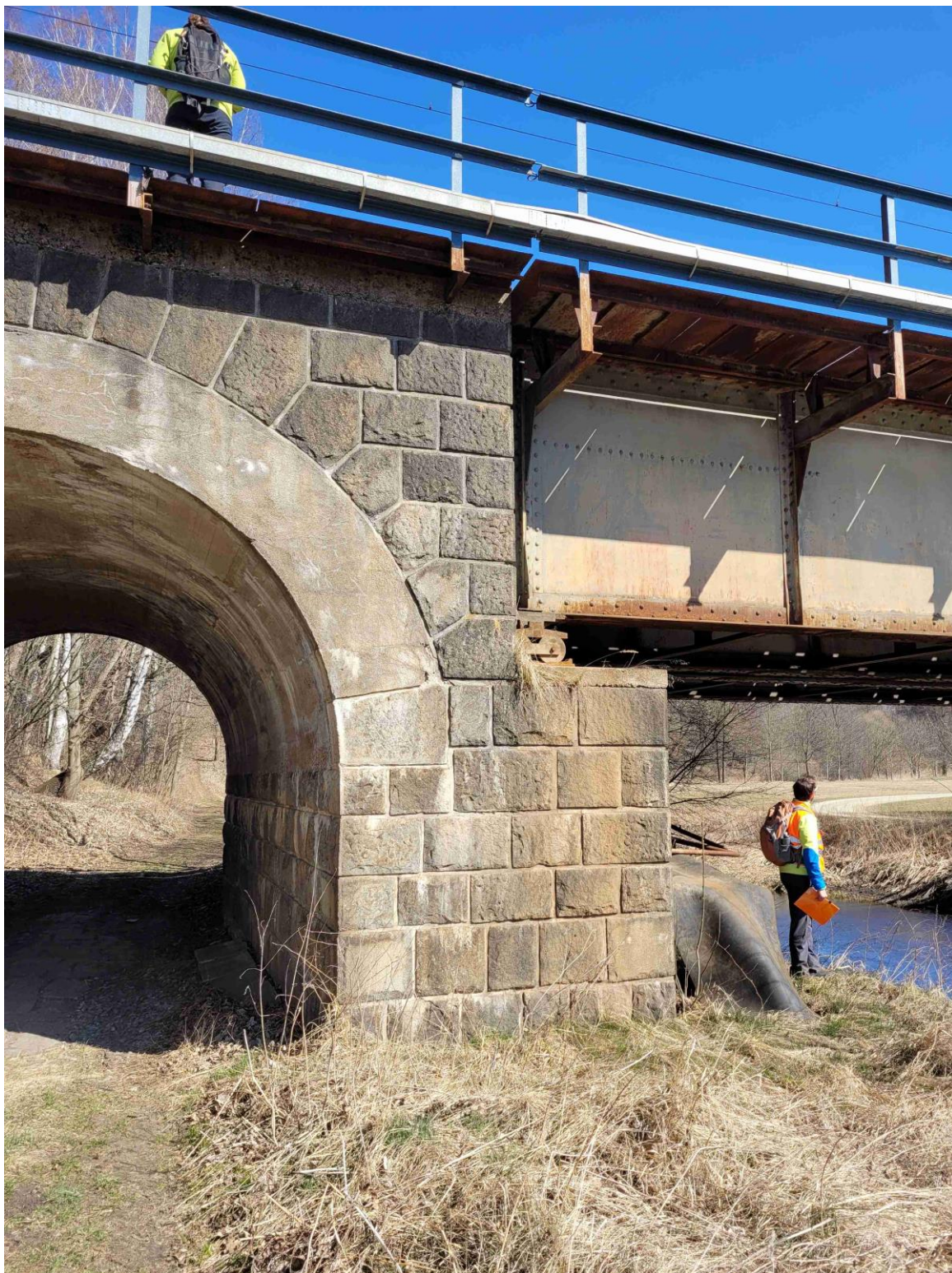
Obr. 17 (22.3.2022, km 112,916) – Most ev. km 112,916. Nosná konstrukce bude vyměněna za novou, kolejové lože bude průběžné. Proběhne sanace spodní stavby.
