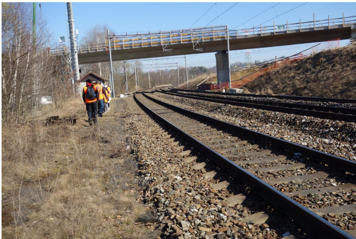
Obr. 4 (22.3.2022, km 115,950) – Stav železničního svršku koleje 90N s nefunkčním odvodněním. Odvodnění zde bude řešeno odřezem na terén (řeší navazující stavba).
