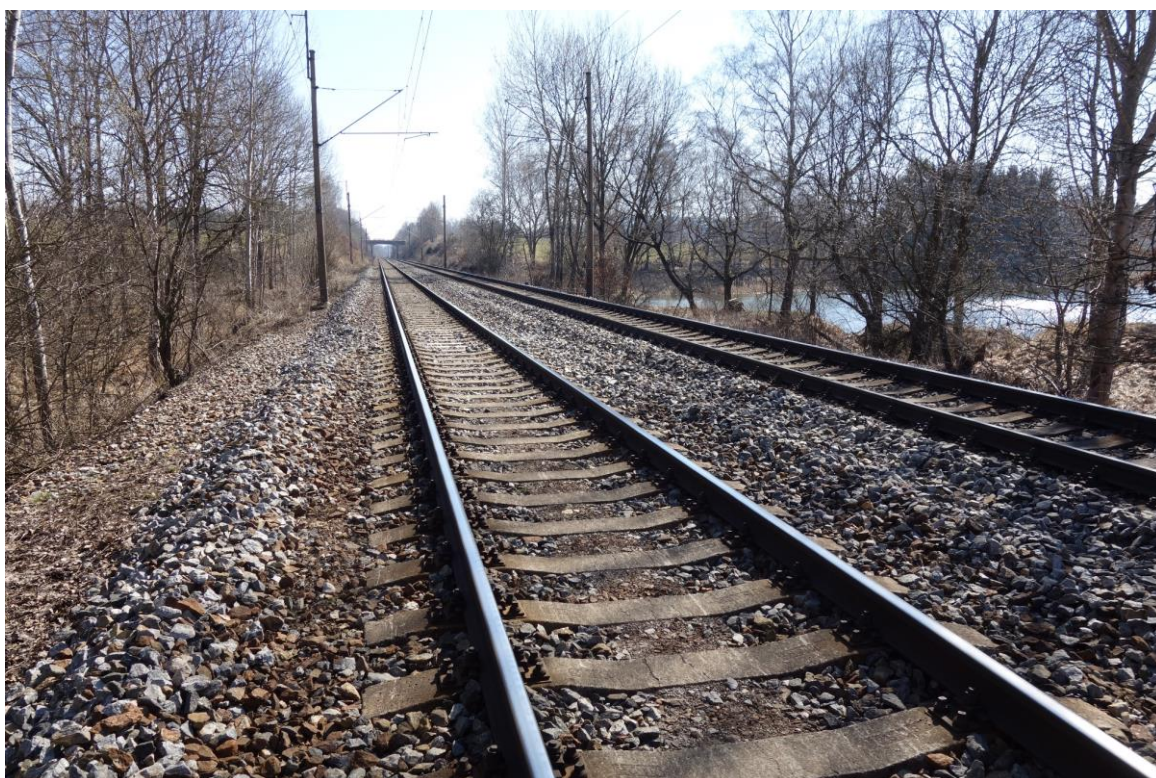
Obr. 14 (22.3.2022, km 113,800) – Pohled na záplavové území vlevo od trati ve směru staničení (na snímku vpravo). Odvodnění koleje č. 1 bude zajištěno odřezem na terén. Svah bude zpevněn pohozem z lomového kamene do úrovně 0,5m nad úroveň Q100.
