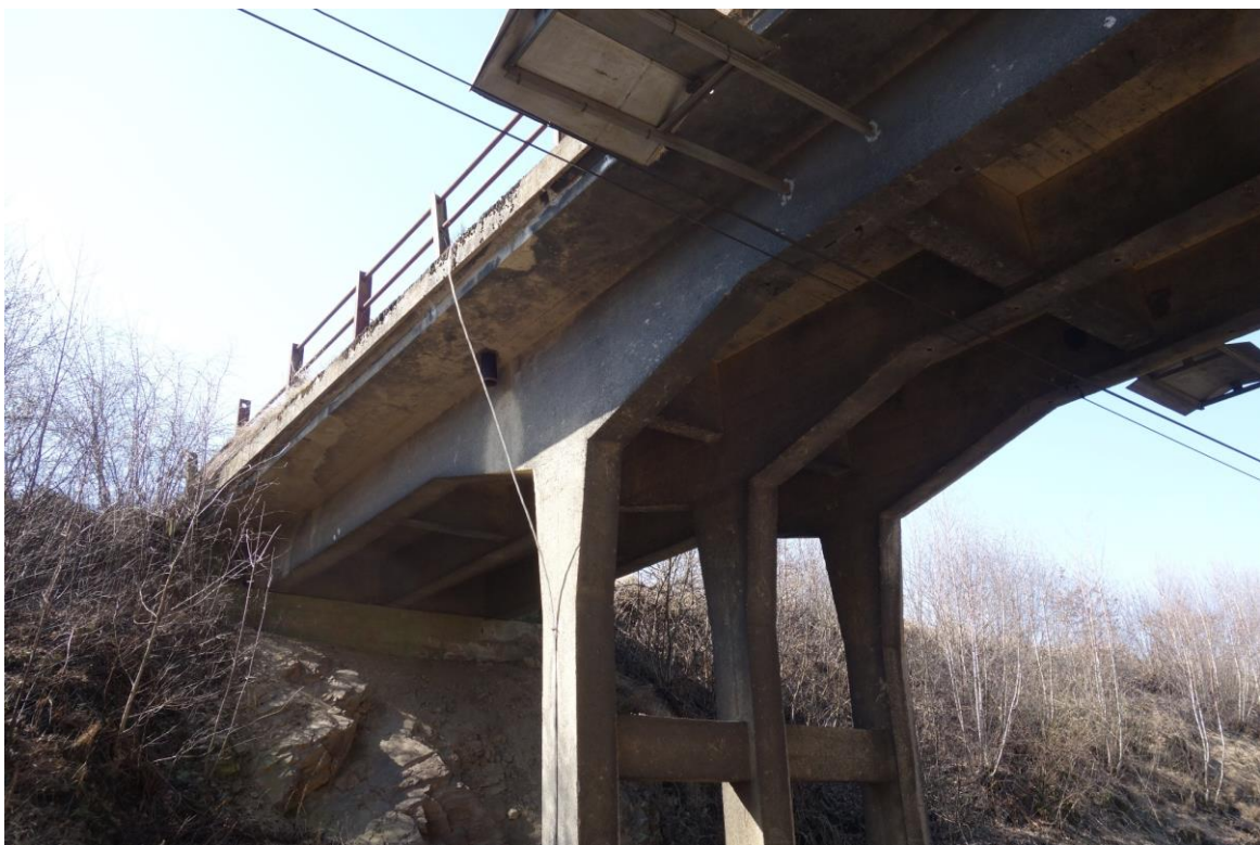
Obr. 16 (22.3.2022, km 113,347) – Nadjezd ev. km 113,347. Z důvodu nedostatečné vzdálenosti pilířů od osy koleje a nepřítomnosti boční ochrany bude nadjezd nahrazen za nový a následně předán správci.
