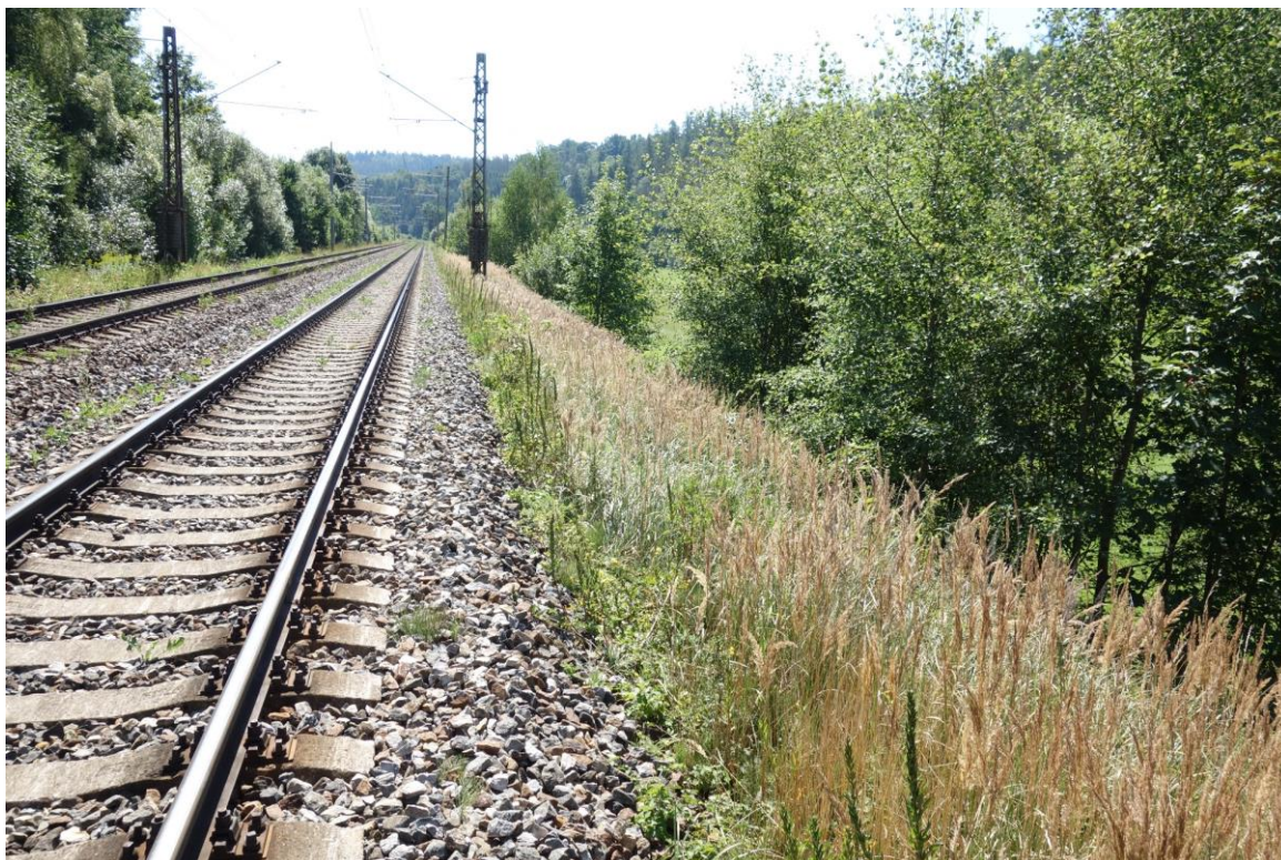
Obr. 18 (5.8.2022, km 112,400) – trať je zde vedena na násypu vedoucím skrz záplavové území. Vlevo od trati (vpravo na snímku) bude obnoven patní příkop, svah bude ochráněn pohozem z lomového kamene do úrovně 0,5m nad Q100.
