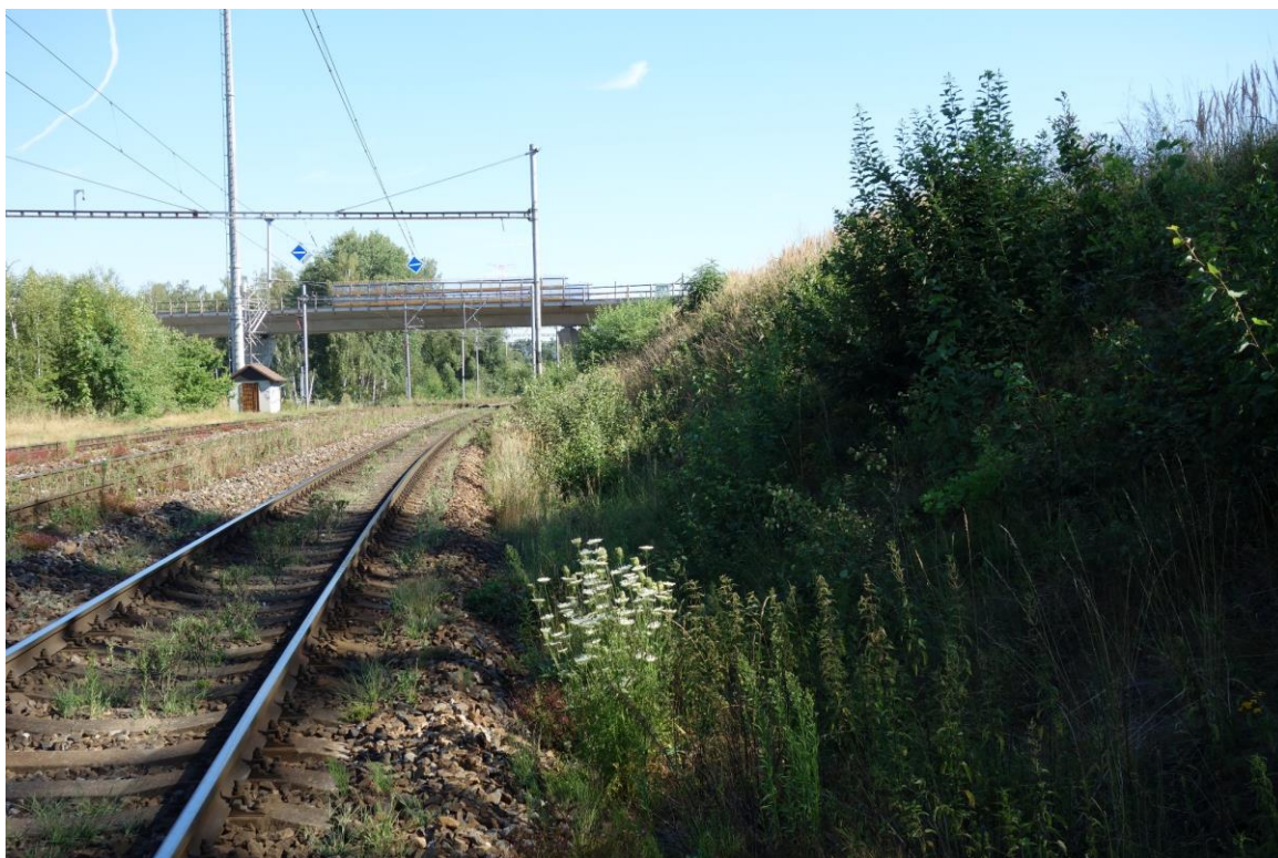
Obr. 2 (22.3.2022, km 115,850) – Pohled na drážní příkop po levé straně. Bude navrženo odvodnění z příkopových žlabů UCH.
