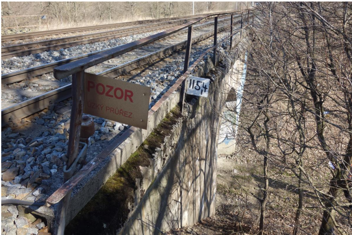
Obr. 6 (22.3.2022, km 115,400) – Úzký průjezdný průřez na mostě ev. km 115,4.
