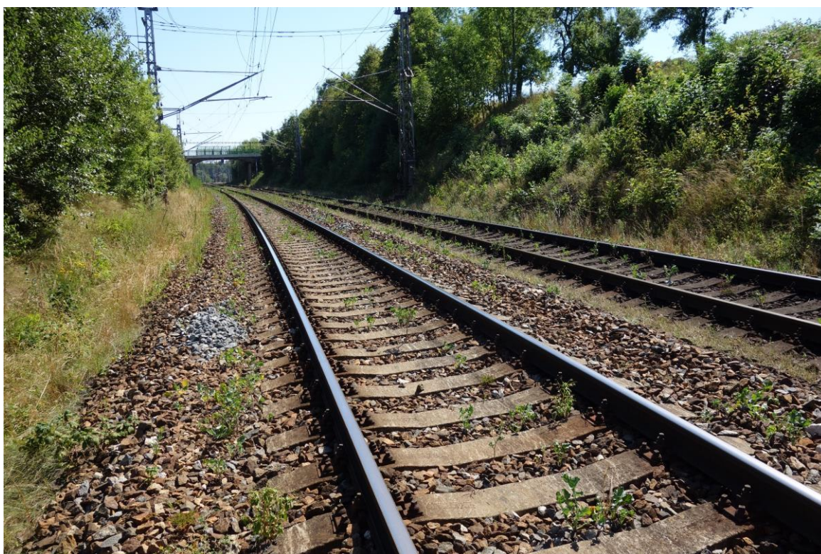
Obr. 19 (5.8.2022, km 111,600) – místo, kde stavba „Modernizace traťového úseku Pohled (mimo) – Havlíčkův Brod (mimo)“ napojuje na předchozí stavbu „Modernizace traťového úseku Přibyslav (včetně) – Pohled (včetně)“. Odvodnění zde je navrženo z příkopových žlabovek UCH.
